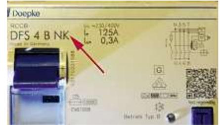
**Bild 32:** »NK« steht für Normkennlinie bei einem B-Typ mit 300 mA Brandschutz und einer Fehlererkennung bis 150 kHz
